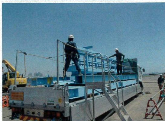
【荷台に取り付けた支柱を利用した親綱の設置、昇降設備の導入】
